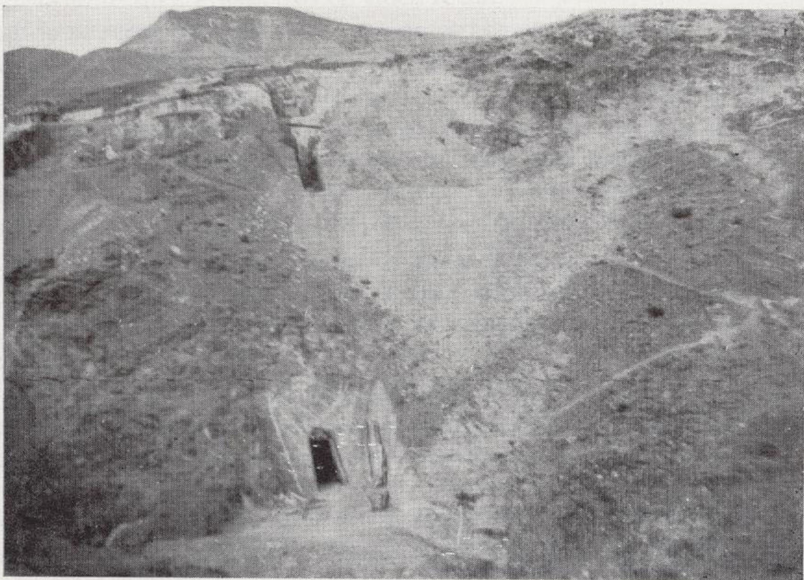
Fot. 33.—Explotación a cielo abierto, con salida de zafras por un socavón inferior, en la mina “Amparín”, de Mijas, Málaga.
