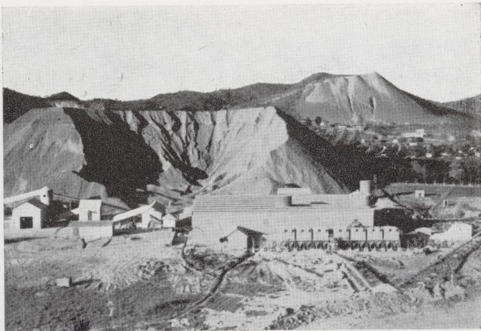
Fot. 16.—Recuperación de la fibra corta de crisotilo, de una escombrera de Shabani, Rhodesia del Sur.
